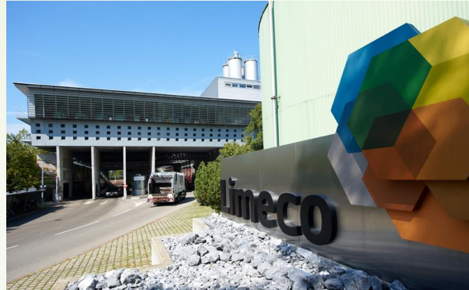
Kläranlageverband Limmattal – LIMECO CH.
