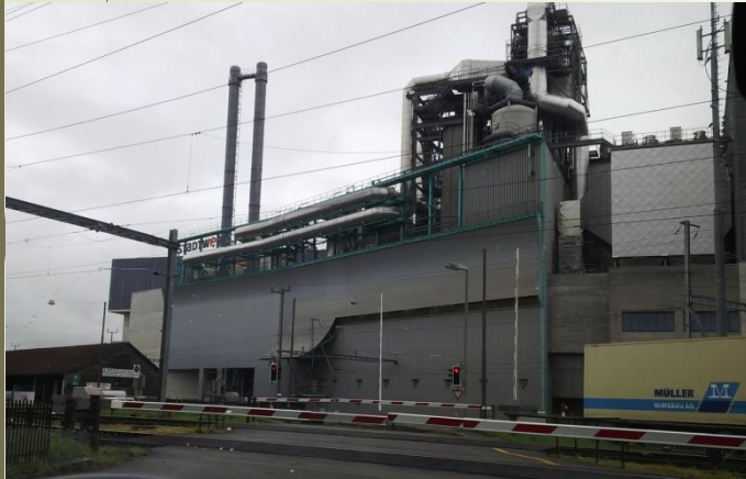
Spaľovňa odpadu - STADTWERK Winterthur CH.
