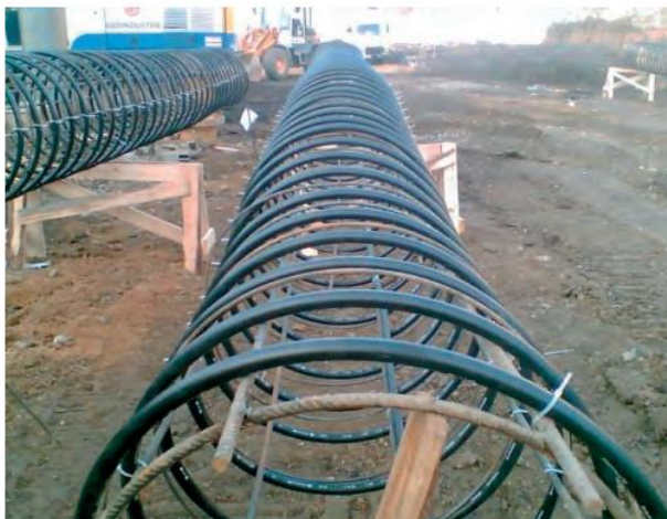
Obr. 5.51 Vystrojená energetická pilota (spirálovitá pokládka) [B10]
