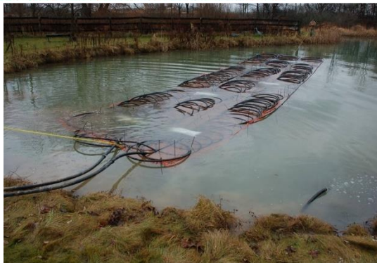
Obr. 5.51 Vystrojená energetická pilota (spirálovitá pokládka) [B10]
