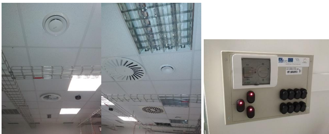
Obr. 7 Výustková trať v laboratóriu C3 – typy výustiek mriežka, anemostat, vírivý anemostat a ovládací panel servoboxu
