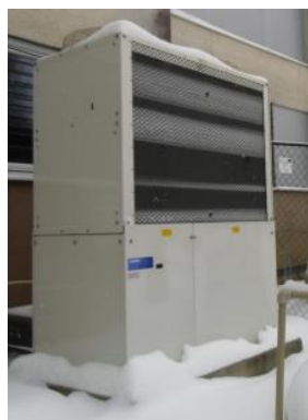
Obr. 43 Plynové tepelné čerpadlo Aisin GHP 10HP
