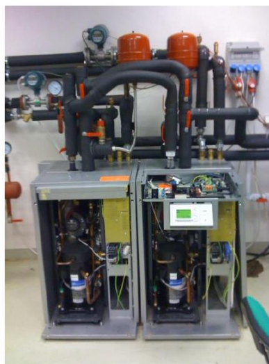
Obr. 42 Elektrické tepelné čerpadlo Viessmann Vitocal 300G BW
