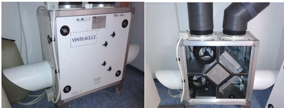
Obr. 8 Vľavo: Vetracia jednotka s rekuperáciou tepla a vývody na meranie diferenčného tlaku na filtroch. Vpravo: Vnútročné usporiadanie jednotky
