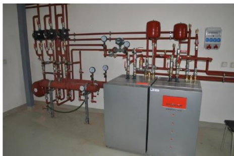
Obr. 42 Elektrické tepelné čerpadlo Viessmann Vitocal 300G BW
