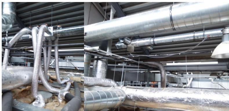
Obr. 6 Výustková trať v laboratóriu C3 – časť nad stropom laboratória
