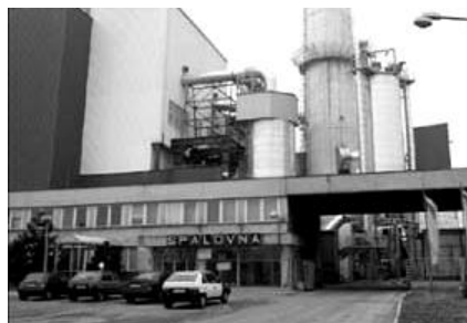
Obr. 5.2 Spaľovňa komunálneho odpadu v Bratislave (1978).
