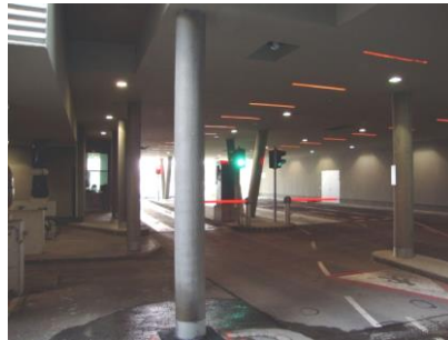
Obr. 4.4 Príjem odpadu – Vážiacie zariadenie (Spaľovňa Viedeň).
