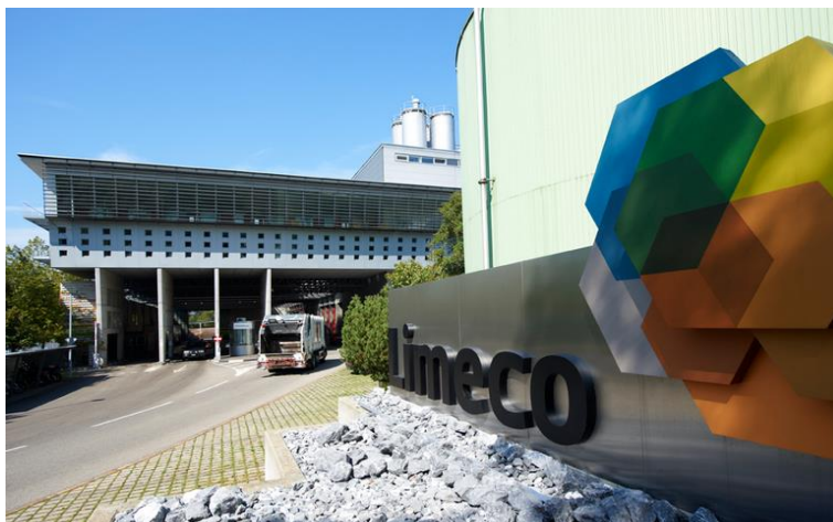
Obr. 5.13 Kläranlageverband Limmattal – LIMECO.
