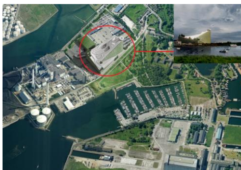
Obr. 5.4 Spaľovňa odpadu v Kodani.
