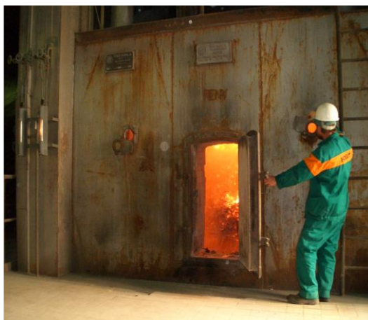
Obr. 5.25 Spaľovňa odpadov, Termovalorizátor – pohľad na súčasne prevádzkovaný kotol. ( http://www.enviroportal.sk/ )
