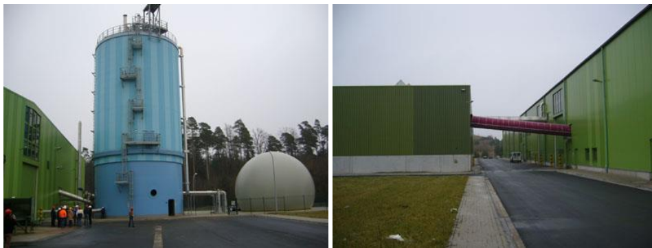
Obr. 11.9 Fermentor s plynojemom (vľavo) a biologická stabilizácia (vpravo).
