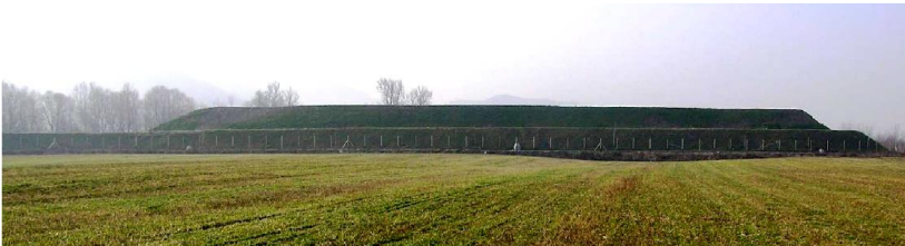
Obr. 7.10 Skládka odpadov Bytča – Mikšová, pohľad na skládku zo severu.
