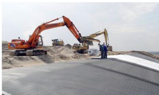
Obr. 7.21 Inštalácia drenážnych geokompozitov pri založení novej skládky.
