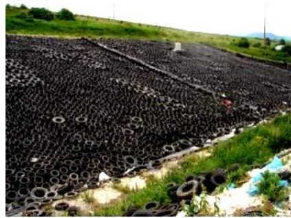
Obr. 7.14 Pohľad na izolačné vrstvy skládky.
