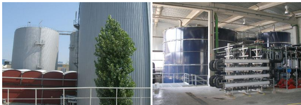
Obr. 11.13 Anaeróbný digestor (vľavo) a ČOV s biologickým stupňom (vpravo).
