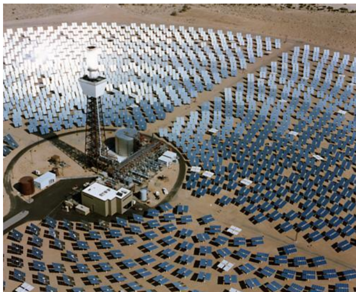
Obr. 10.7 Termálna solárna veža (Slpk, 2020).
