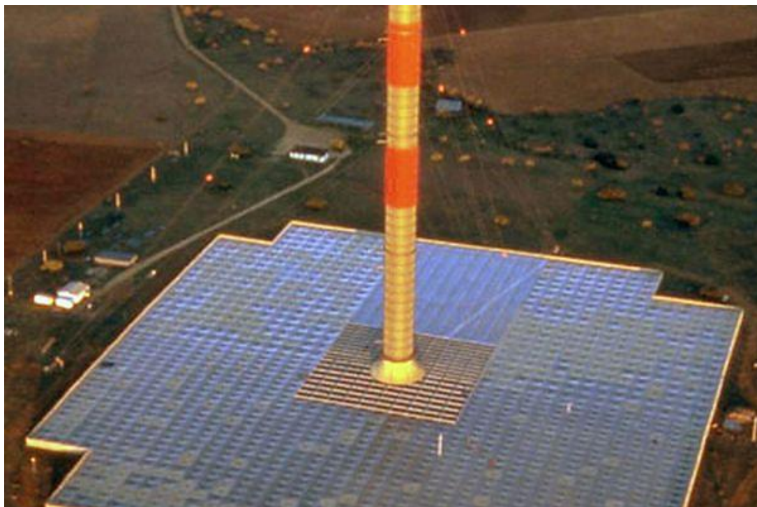
Obr. 10.9 Komínová slnečná elektráreň (Volumatrixgroup, 2022).
